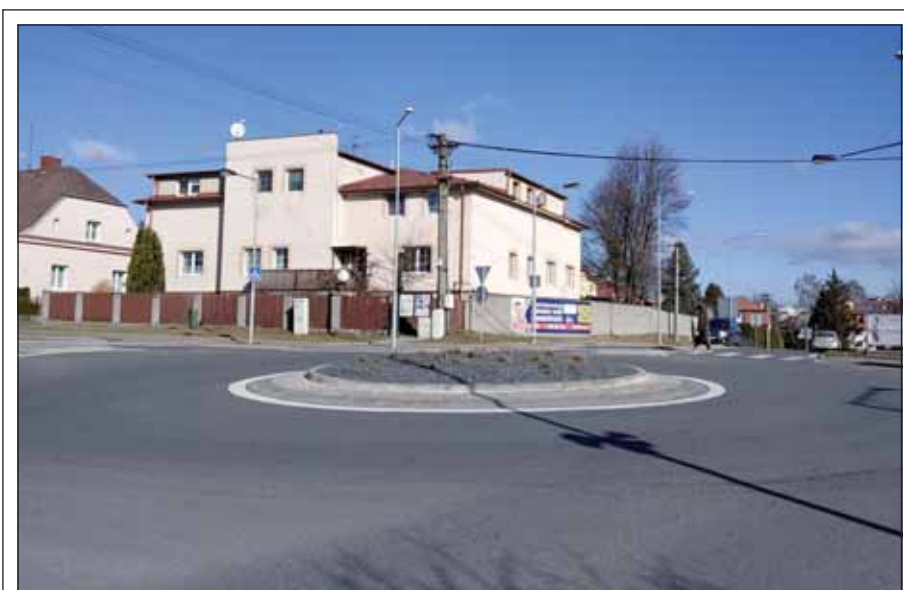
Jedna z investičních akcí realizovaná technickou správou v roce 2021 – úprava a osázení středového objektu kruhového objezdu trvalkami.
